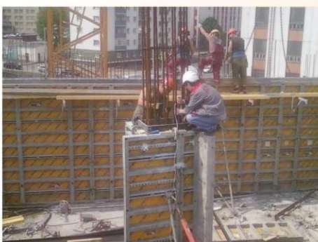
Тензодатчики на железобетонной арматуре
